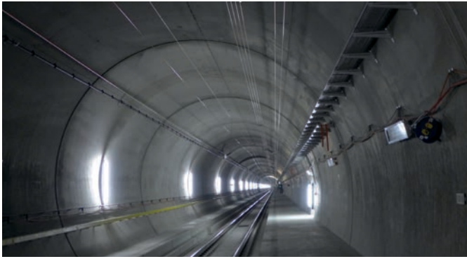
Abb. 1: Innenansicht Gotthard Tunnel
