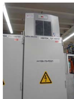
DTT-Dachkühlgeräte verhindern zuverlässig das Eindringen von Kondensat in Schaltschränke
