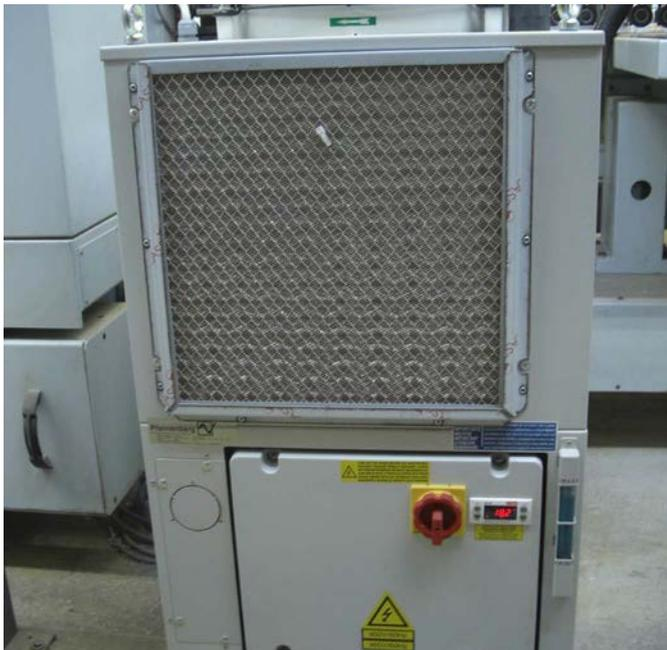
Der Rückkühler EB60 WT CE mit einer Kühlleistung von 6 kW kühlt die zwölf Untergruppen-Schaltschränke entlang der Kantenleimmaschine.
