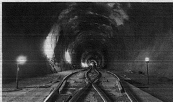
Riesige Baustelle unter dem Gotthard-Massiv: Mit einer Länge von 57 Kilometern entsteht der längste Eisenbahntunnel der Welt.
